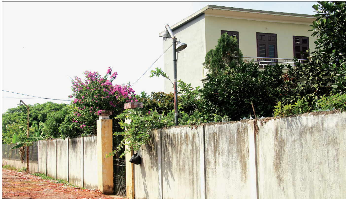
Nhà xây kiên cố trái phép trên đất nông nghiệp tại xã Vũ Chính (thành phố Thái Bình).
