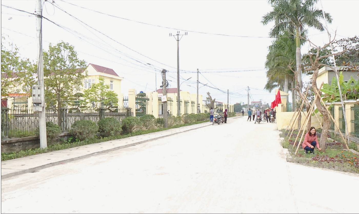
Đường giao thông nông thôn xã Thái Dương được mở rộng thuận lợi cho việc đi lại của người dân.
