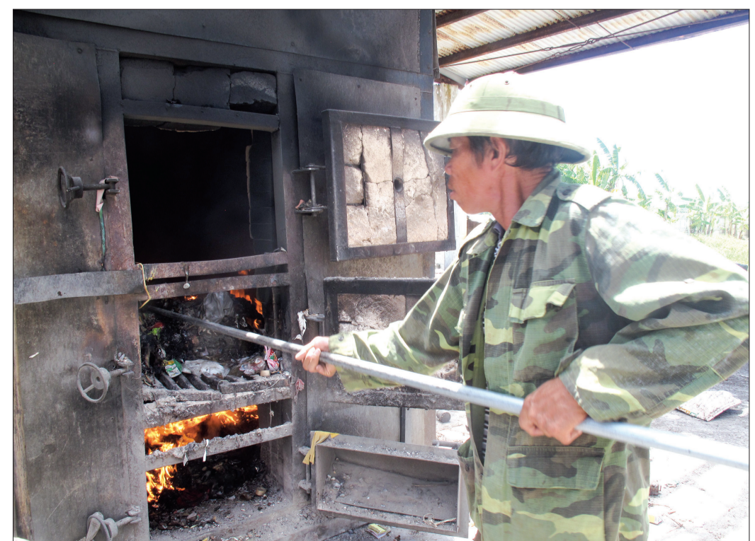
Công nhân vận hành lò đốt rác.
