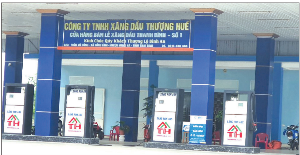
Cửa hàng bán lẻ xăng dầu Thanh Bình tại xã Hồng Lĩnh, huyện Hưng Hà của Công ty TNHH Xăng dầu Thượng Huế hoạt động khi chưa được cấp phép.
