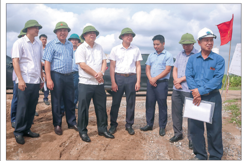
Đồng chí Nguyễn Quang Hưng, Ủy viên Ban Thường vụ Tỉnh ủy, Phó Chủ tịch thường trực UBND tỉnh kiểm tra tiến độ thi công công trình cầu sông Hồng thuộc dự án tuyến đường bộ ven biển.
