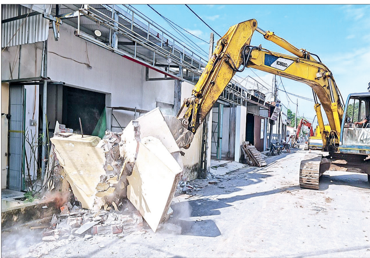
Người dân xã An Thái (Quỳnh Phụ) tự nguyện hiến đất làm đường.
