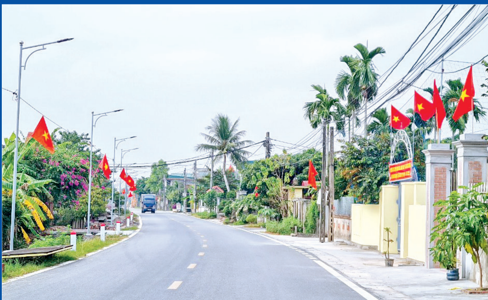
Đường ĐH.53 qua xã Hà Giang (Đông Hưng) được cải tạo, nâng cấp, nhân dân phấn khởi đóng góp kinh phí lắp điện chiếu sáng làm đẹp tuyến đường.
