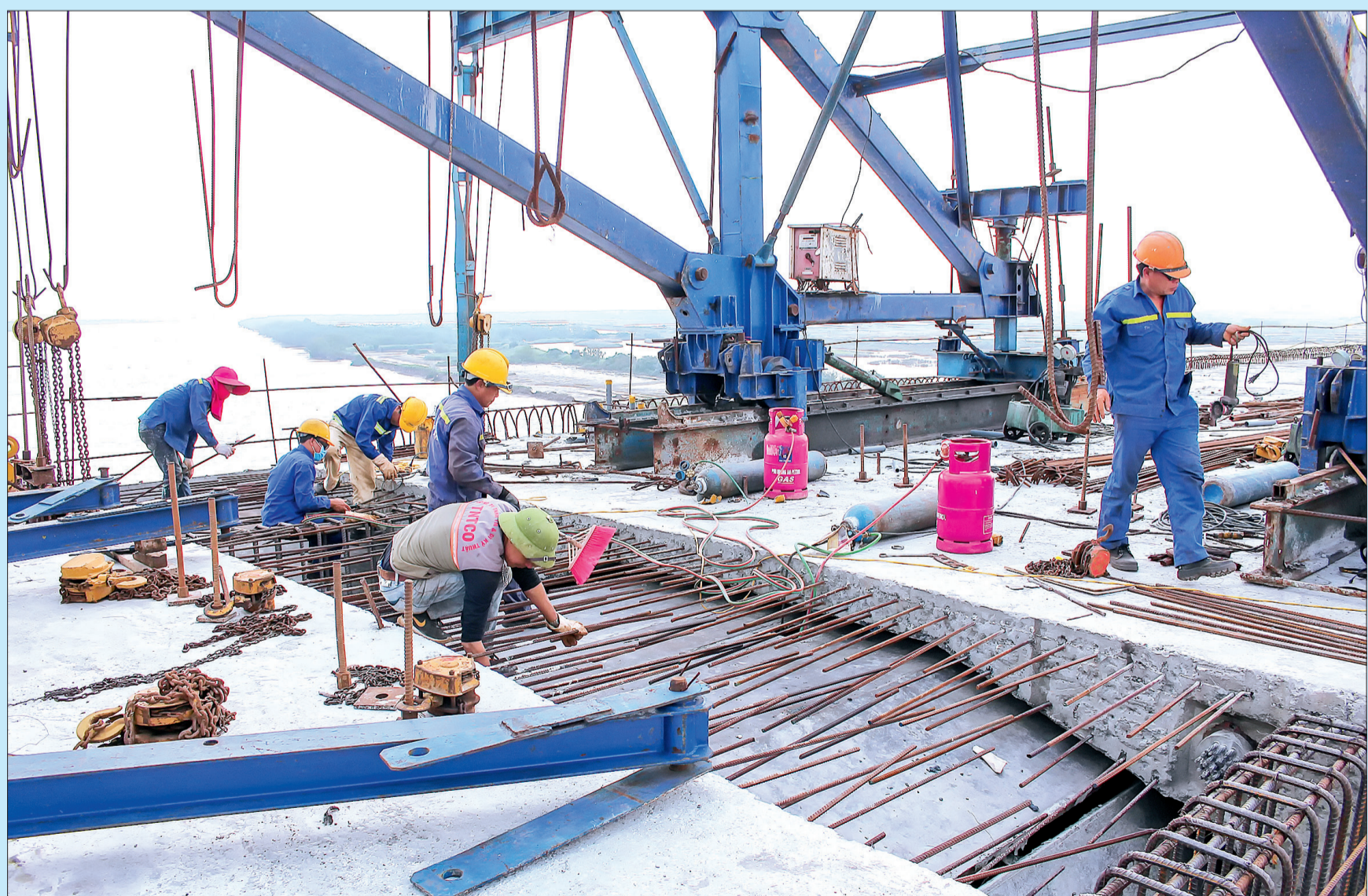
Công nhân tích cực thi công hoàn thành các hạng mục còn lại để sớm hợp long cầu vượt sông Trà Lý.
