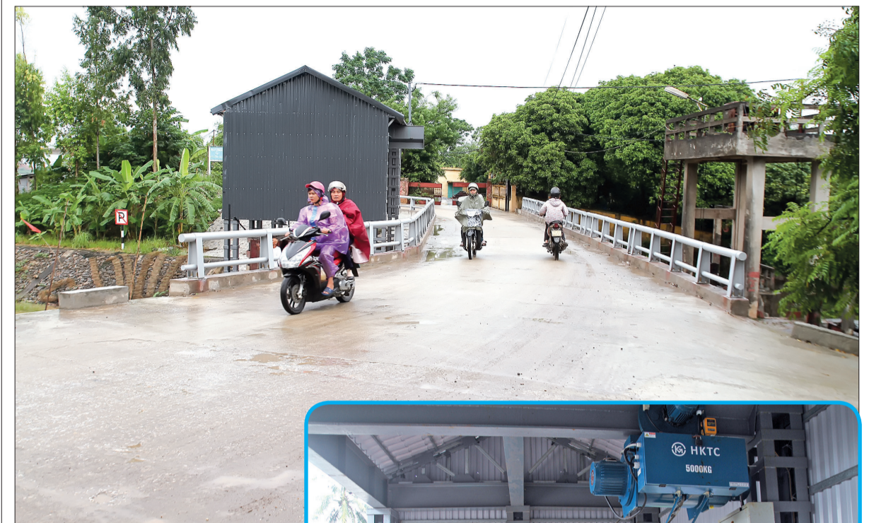
Cống Hiệp được sửa chữa, nâng cấp đã tạo thuận lợi cho giao thông, thủy lợi của huyện Quỳnh Phụ.
