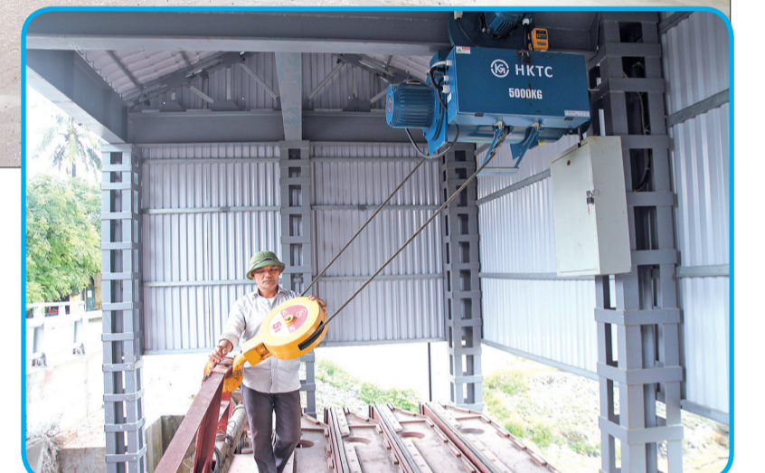
Công nhân cống Hiệp vận hành hệ thống kéo thả phai bằng pa lăng điện.
