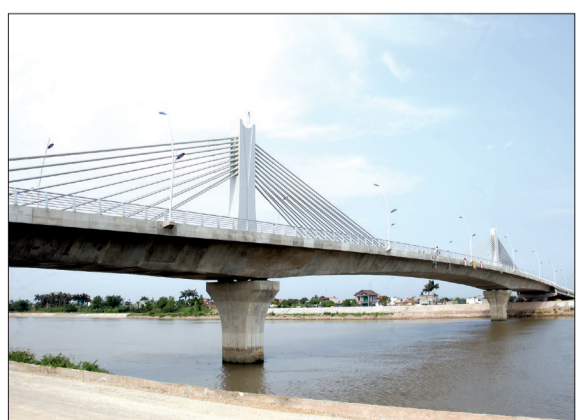
Cầu vượt sông Trà Lý.
