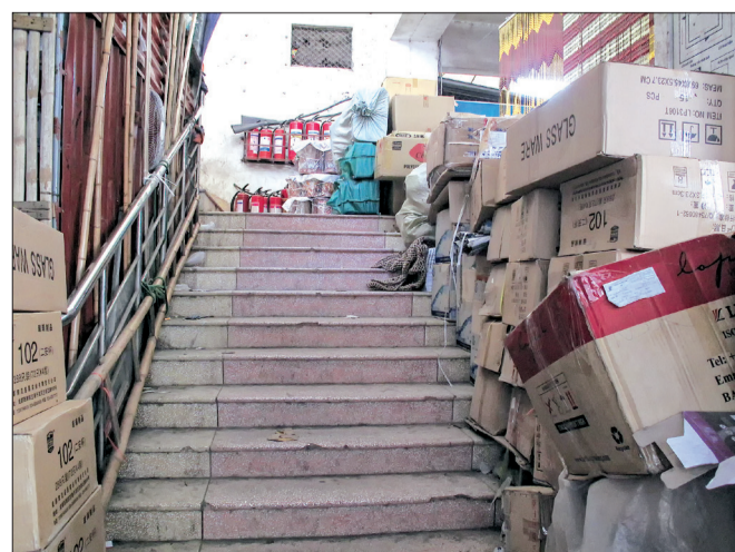
Bình cứu hỏa bị hàng hóa lấn chiếm, che khuất tầm nhìn.
