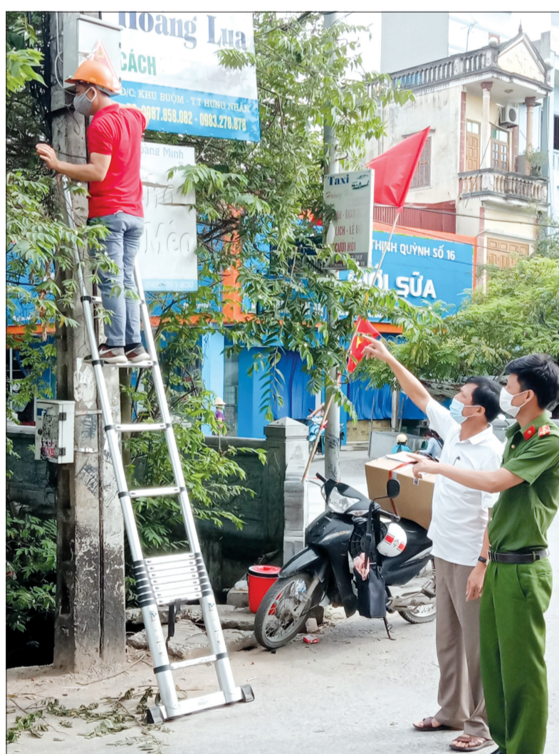
Kiểm tra việc lắp đặt hệ thống camera an ninh tại thị trấn Hưng Nhân (Hưng Hà).
