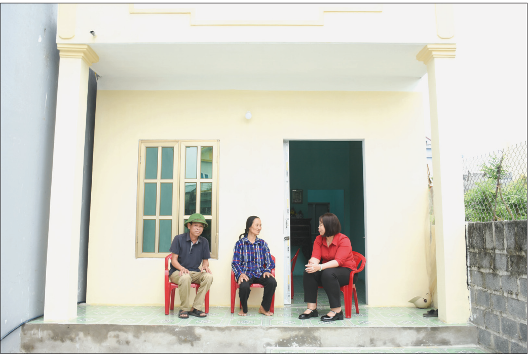
Bà Phạm Thị Út (người ở giữa), xã Quỳnh Hưng (Quỳnh Phụ) yên tâm hơn với ngôi nhà mới được xây dựng kiên cố.
