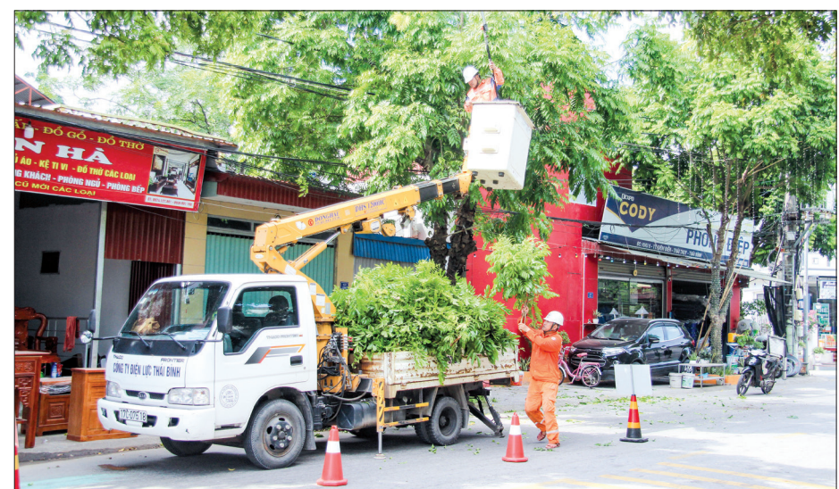
Công ty Điện lực Thái Bình tổ chức phát quang hành lang lưới điện, giảm thiểu thiệt hại do bão số 3 gây ra.
