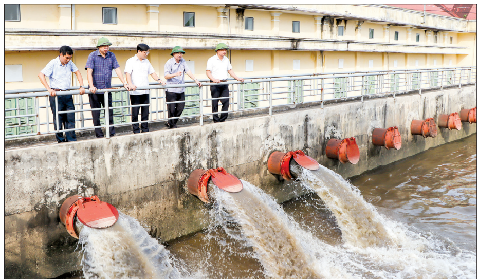
Đồng chí Phạm Đồng Thụy, Ủy viên Ban Thường vụ, Trưởng ban Tuyên giáo Tỉnh ủy kiểm tra công tác tiêu thoát nước tại trạm bơm Lịch Bài, xã Vũ Hòa (Kiến Xương).
