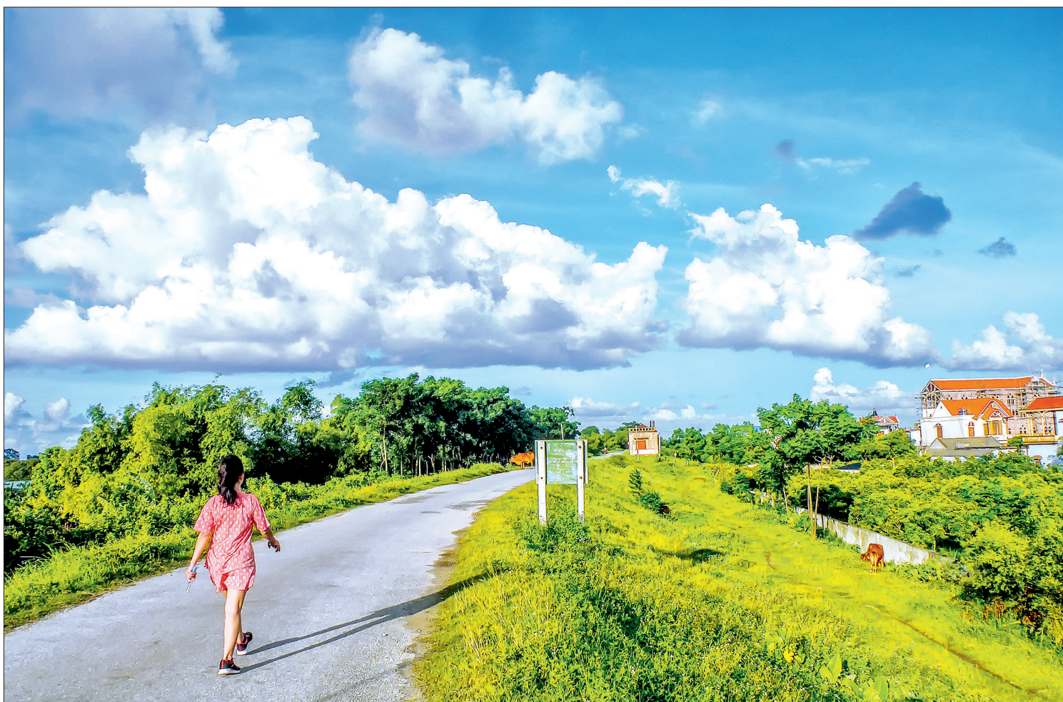
Đoạn đê bị thấm lậu dẫn đến vỡ đê năm 1907 thuộc địa phận giáo xứ Quan Khê, xã Tân Lễ, huyện Hưng Hà.
