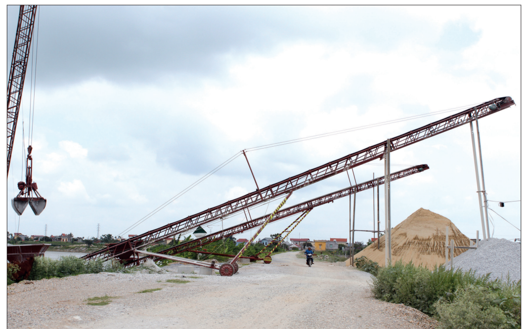
Hệ thống băng tải chất tải vật liệu xây dựng qua đê của Công ty TNHH Thương mại và Vận tải Tín Thành Hưng.
