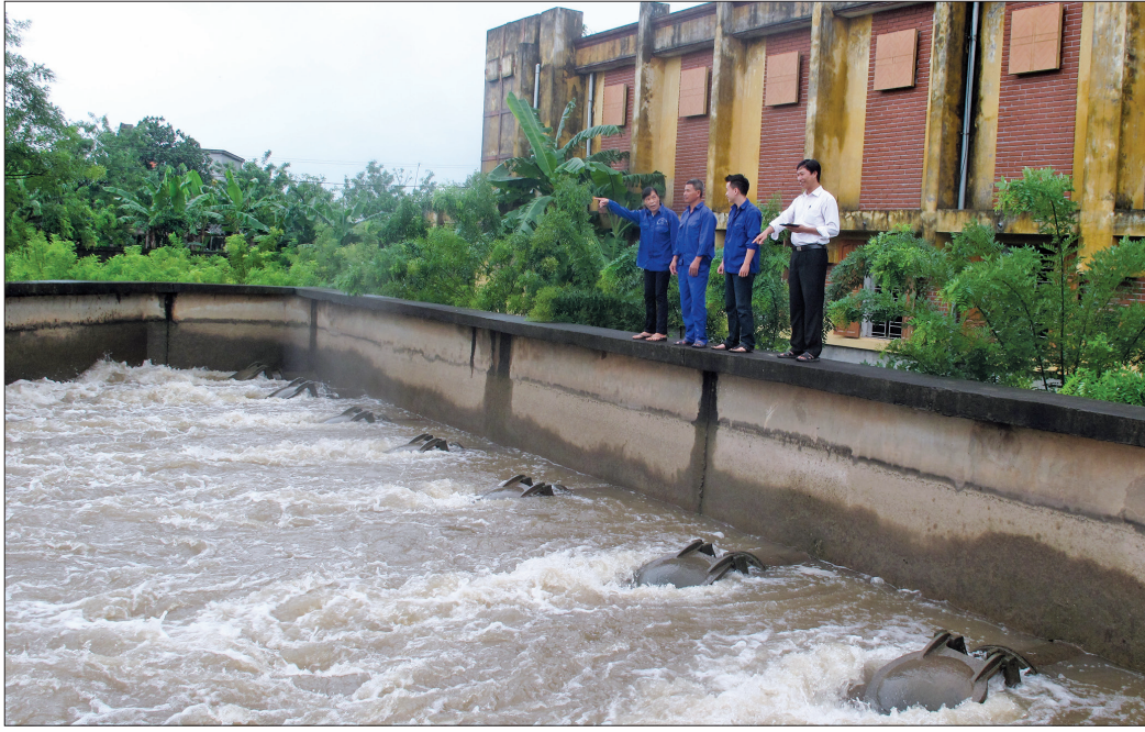
Trạm bơm Cao Nội (Quỳnh Phụ).
