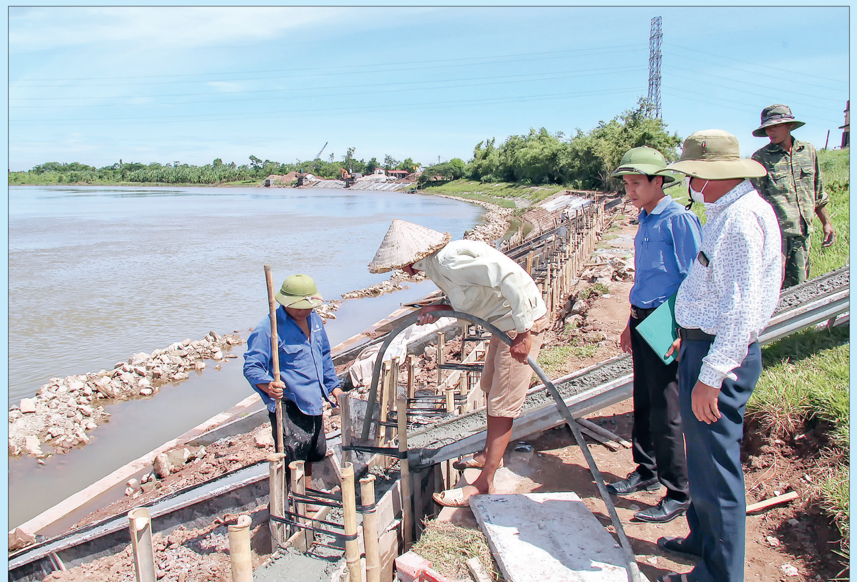
Chủ đầu tư, cán bộ kỹ thuật thường xuyên kiểm tra, giám sát việc thi công các công trình.
