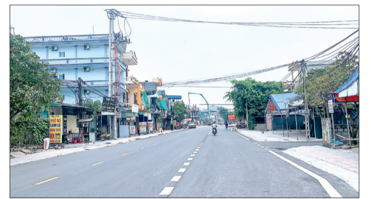
Điện mào xã Tân Bình, thành phố Thái Bình.
