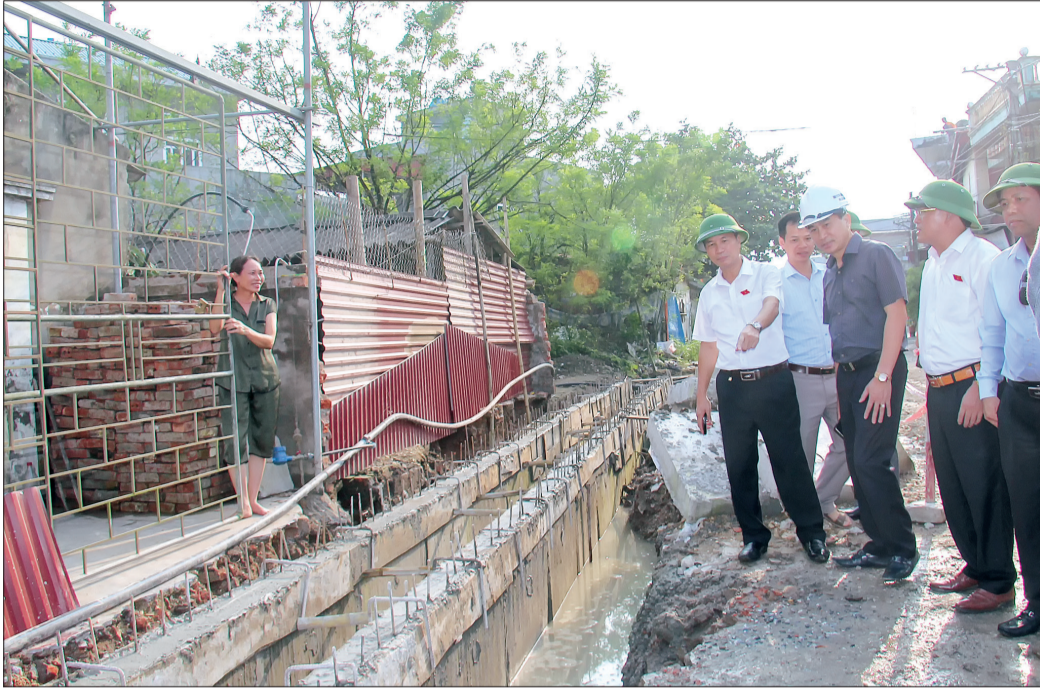
HĐND tỉnh giám sát thực tế công trình đường ĐH.72 chạy qua địa phận huyện Quỳnh Phụ.
