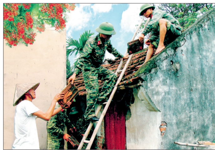
Cán bộ, chiến sĩ Ban CHQS huyện Vũ Thư giúp dân lợp lại mái nhà trong khắc phục hậu quả bão.
