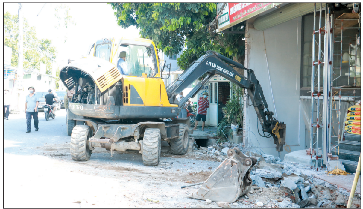
Giải phóng mặt bằng phục vụ thi công dự án nâng cấp, cải tạo đường ĐT.455, nối từ đường Thái Bình - Hà Nam đến UBND xã Tây Đà (Hưng Hà).
