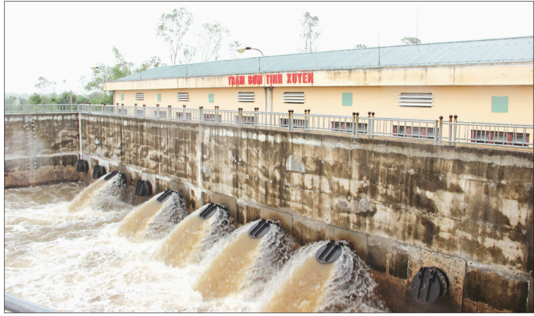
Hiện nay, các đơn vị, địa phương đang khẩn trương tu bổ, sửa chữa máy móc, thiết bị công trình, bảo đảm vận hành an toàn để phục vụ sản xuất và phòng, chống lụt, bão.
