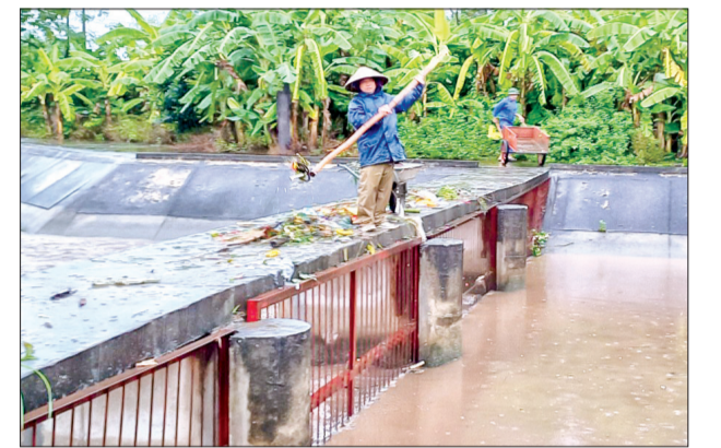
Công nhân Trạm bơm Tĩnh Xuyên (Hưng Hà) thu vớt vật cản tạo thuận lợi cho việc bơm nước.
