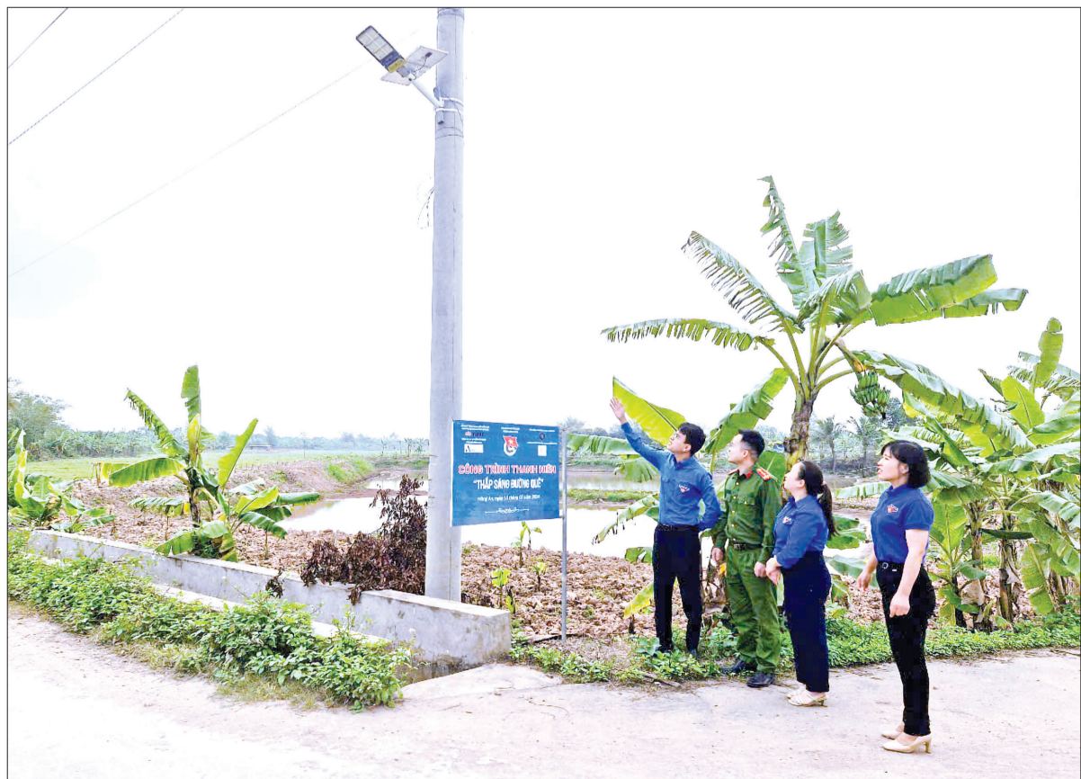
Một công trình "Thấp sáng đường quê" tại xã Hồng An (Hưng Hà).
