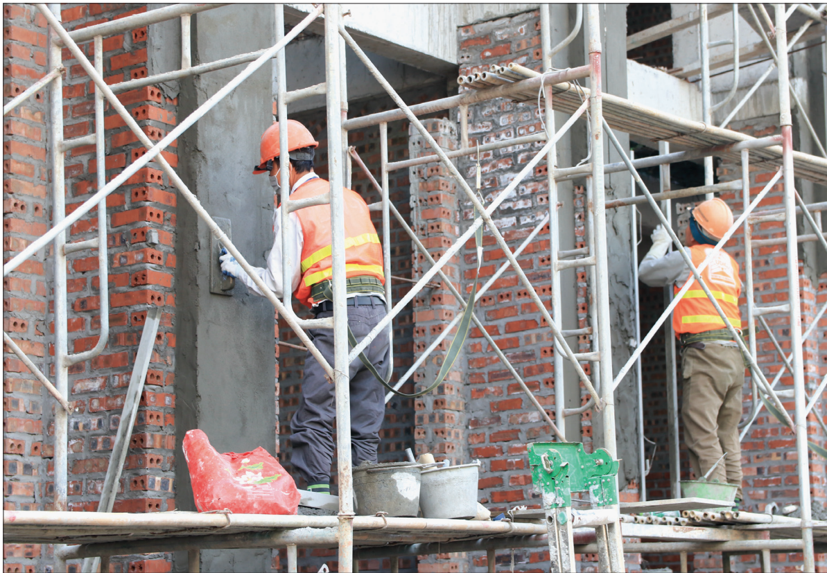
Thi công dự án phát triển nhà ở thương mại khu dân cư phường Bồ Xuyên, thành phố Thái Bình.
