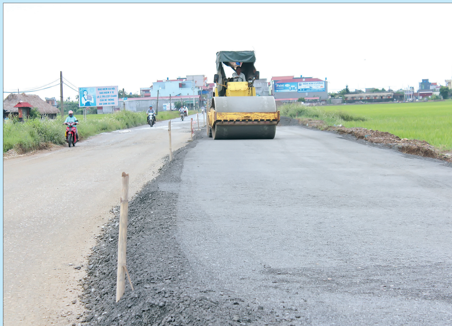
Dự kiến đơn vị thi công tuyến đường ĐT.456 sẽ hoàn thiện và bàn giao đưa vào sử dụng cuối năm 2018.
