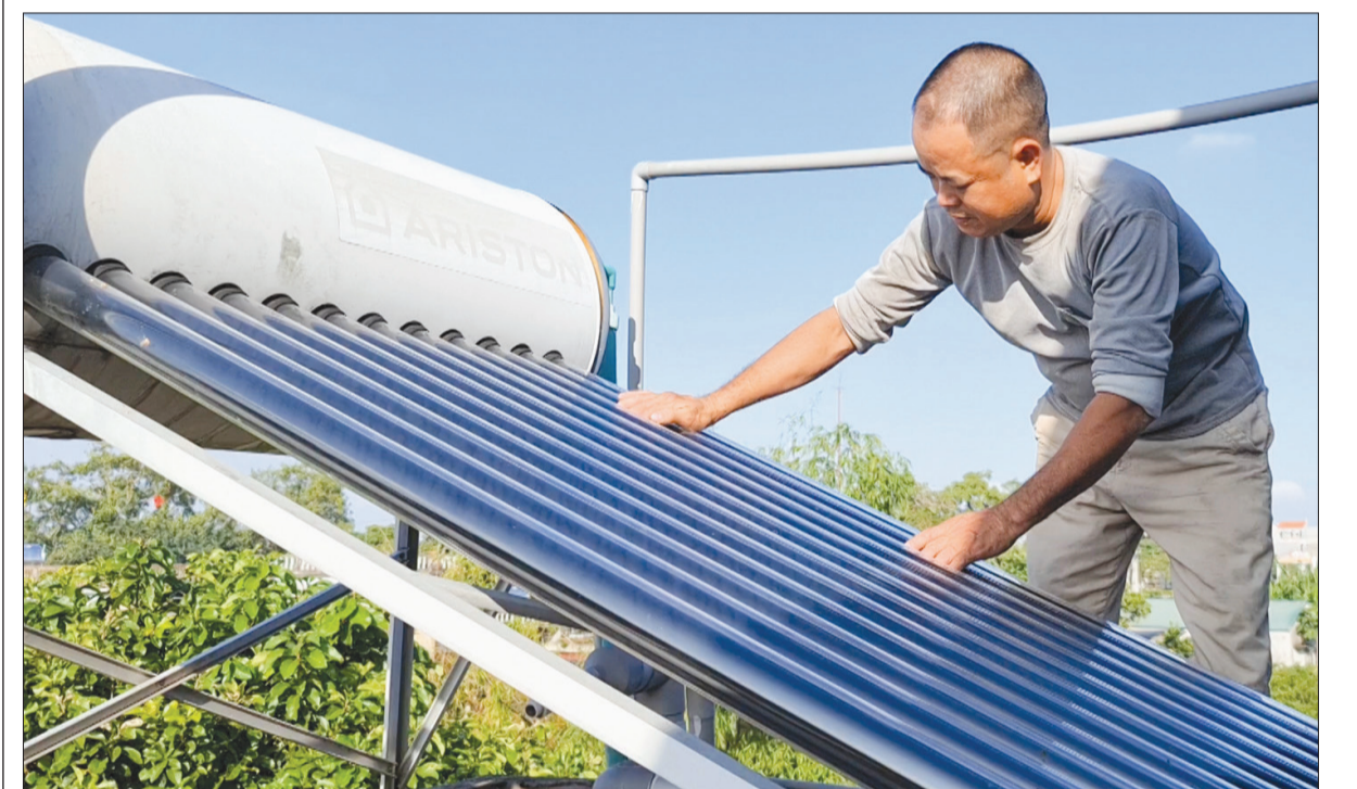
Gia đình ông Vũ Văn Cách, thôn Hành Dũng Nghĩa, xã Duy Nhất (Vũ Thu) lắp đặt bình nước nóng năng lượng mặt trời phục vụ sinh hoạt.
