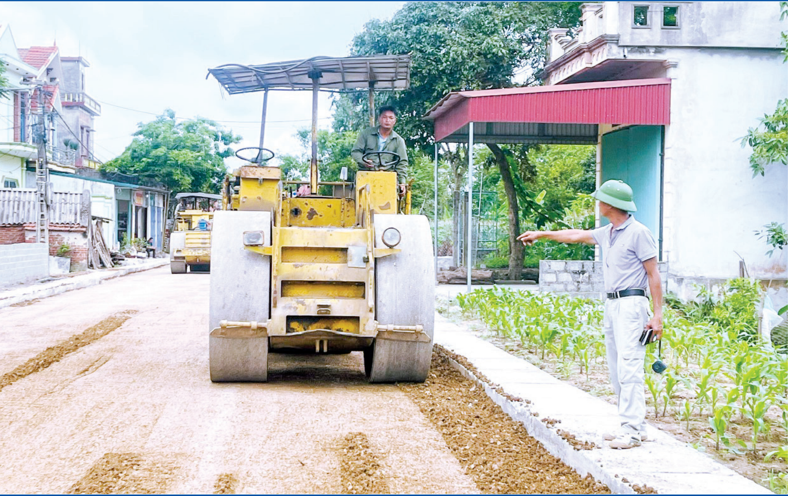
Thi công mở rộng tuyến đường tại xã Tân Hòa (Hưng Hà).
