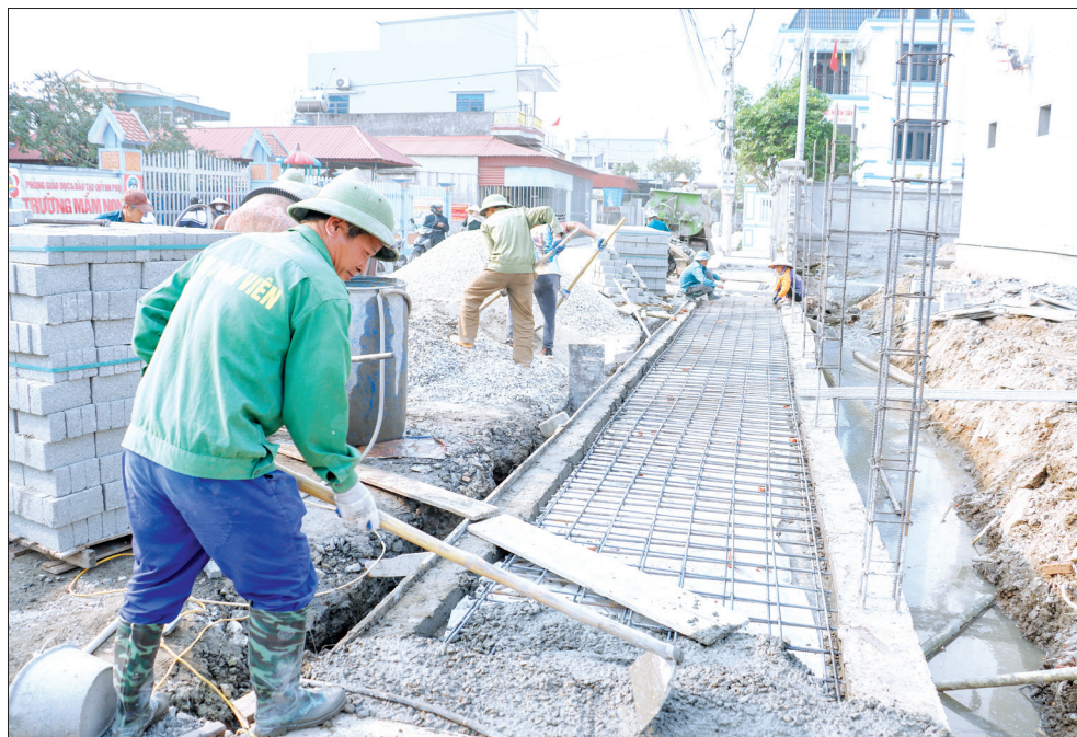
Các dự án sử dụng vốn đầu tư công trên địa bàn xã Quỳnh Hưng (Quỳnh Phụ) đang được đẩy nhanh tiến độ.
