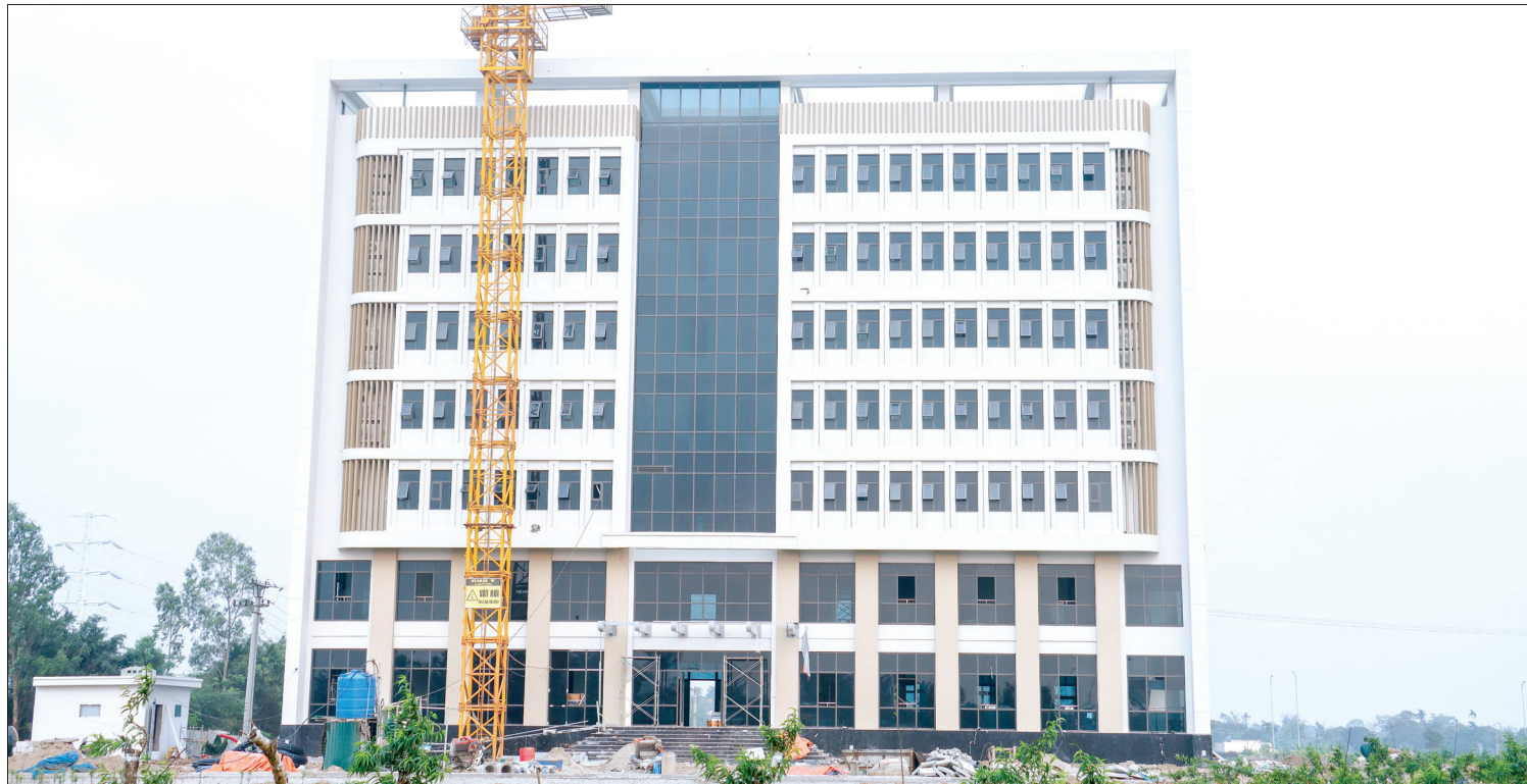
Công trình Kho lưu trữ chuyên dụng tỉnh Thái Bình tại phường Hoàng Diệu (thành phố Thái Bình) đang được gấp rút hoàn thiện.
