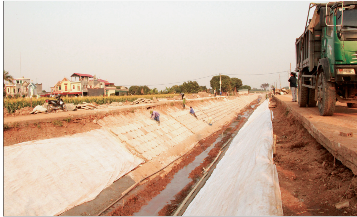
Dự án xử lý cấp bách công trình nạo vét, kè lát mái và cải tạo công trình phụ trợ sông Tân Mỹ, xã Quỳnh Giao (Quỳnh Phụ) đang được khẩn trương thi công.
