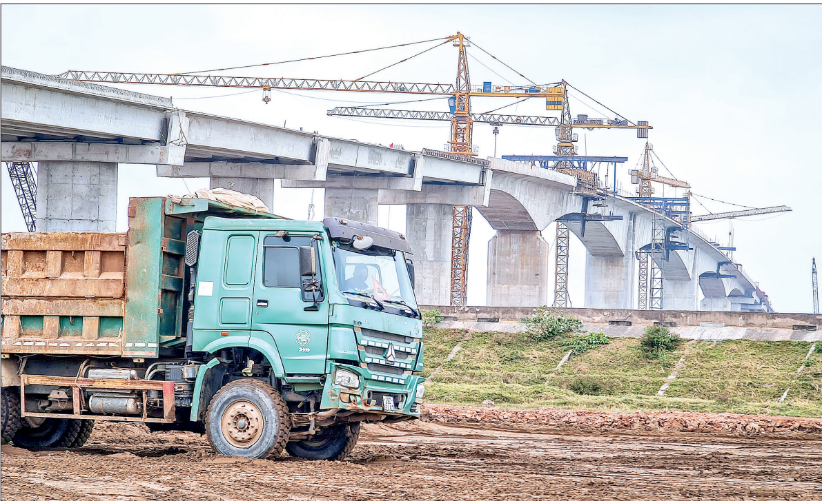
Cầu vượt sông Trà Lý trên tuyến đường bộ ven biển tỉnh Thái Bình sắp hợp long.
