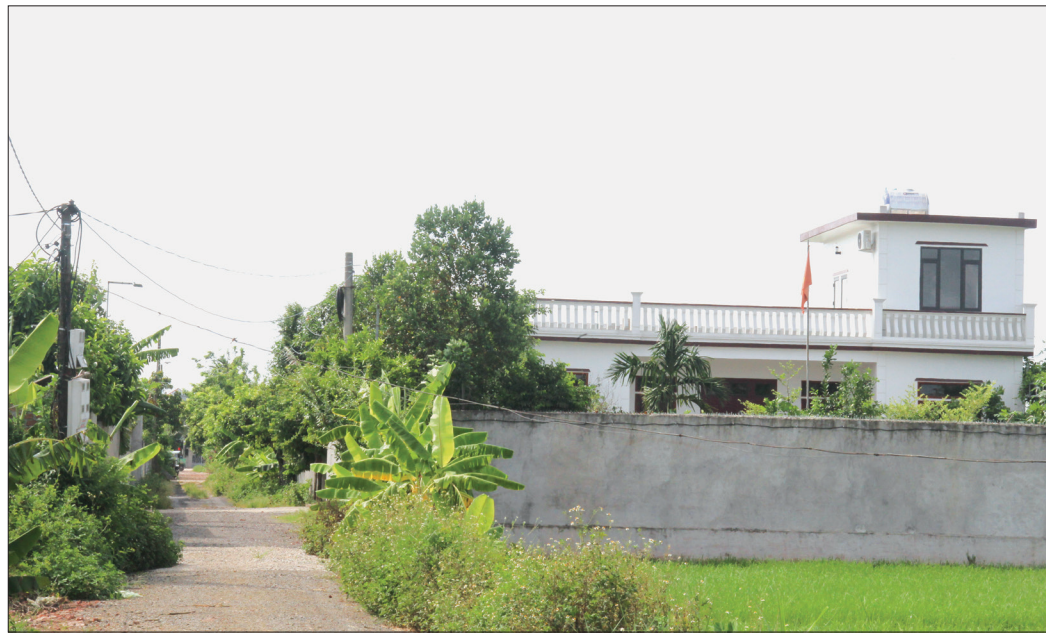
Nhà cao tầng xây dựng không phép trên đất nông nghiệp tại thôn Vũ Trường, xã Vũ Chính (thành phố Thái Bình).
