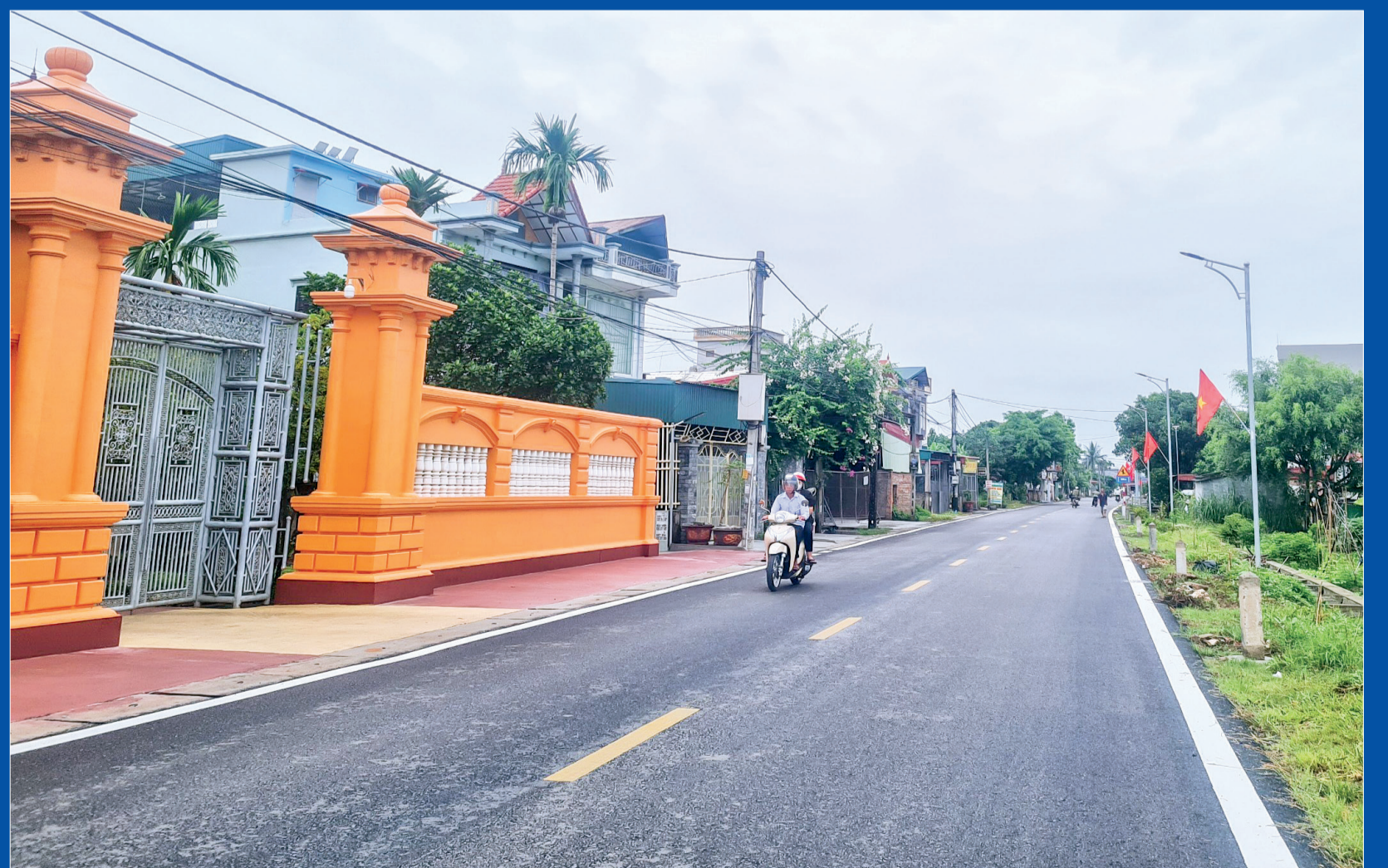
Đường ĐH.53 đoạn qua xã Hà Giang (Đông Hưng) đã hoàn thành và đưa vào sử dụng.
