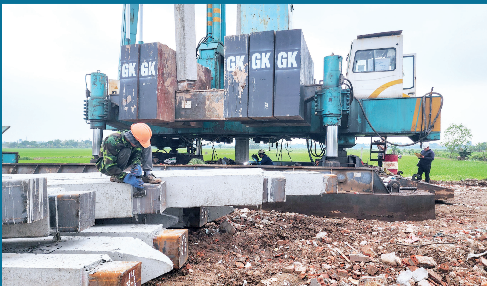
Đẩy nhanh tiến độ thi công dự án đường dây 500kV đoạn qua xã Tư Tân (Vũ Thư).
