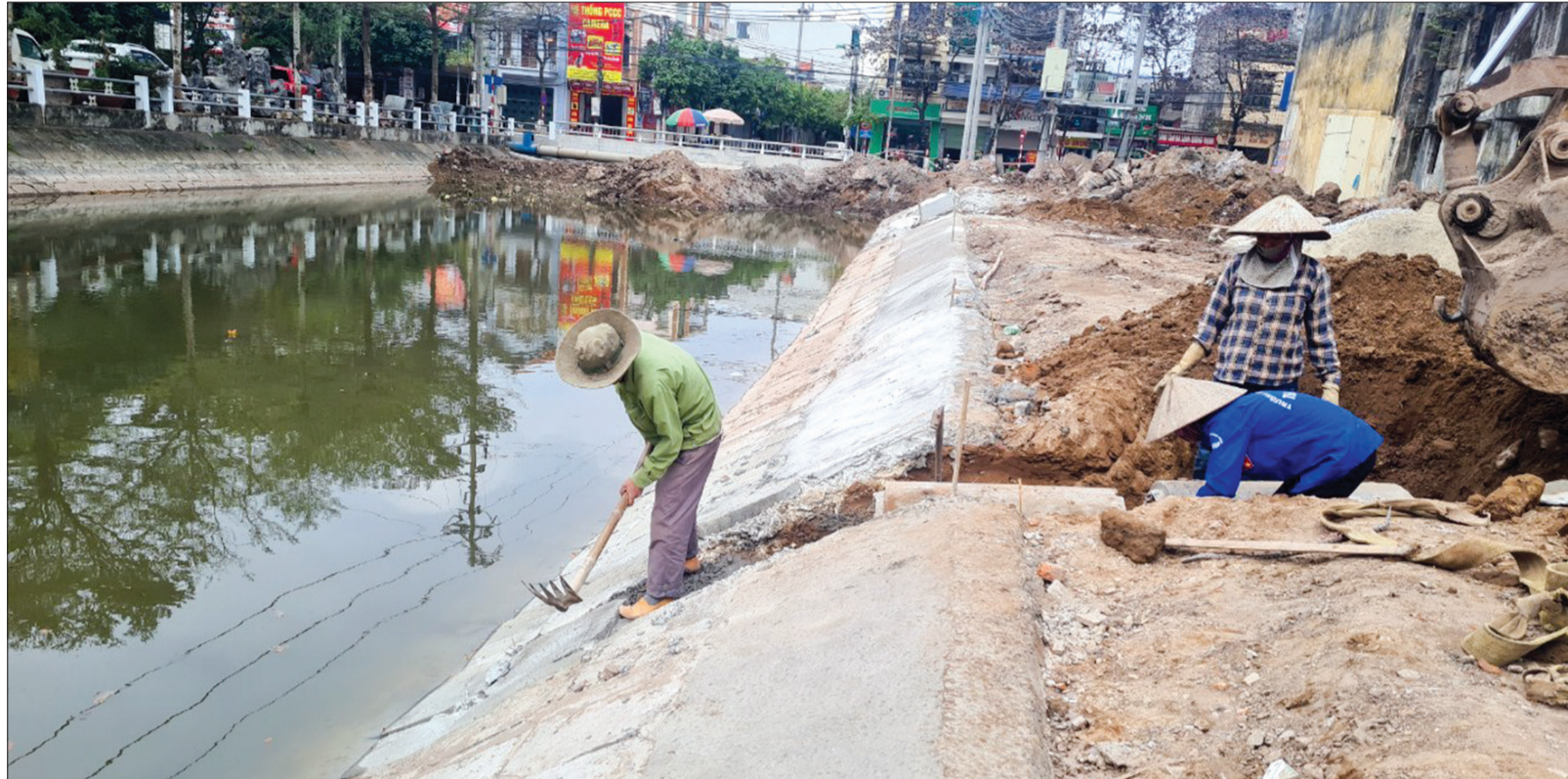
Thi công kè tại nút giao đường Lý Thường Kiệt - Ngô Quyền.
