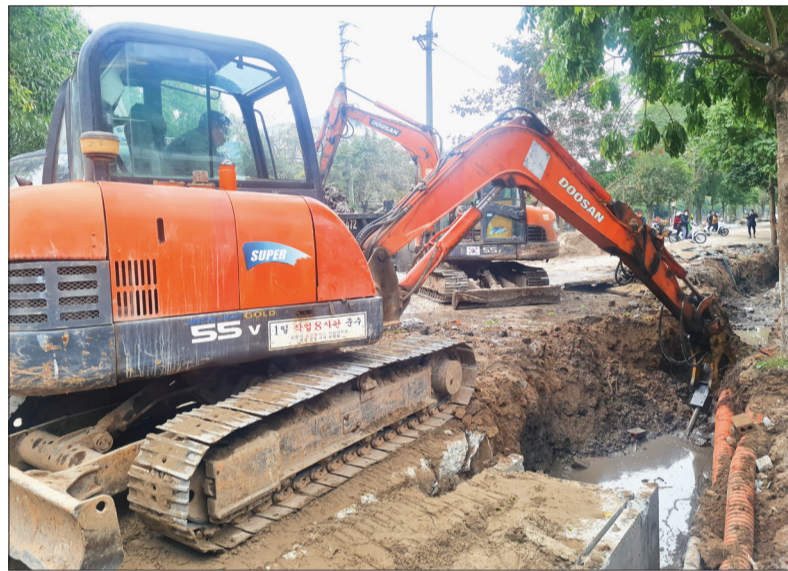
Đơn vị thi công đẩy nhanh tiến độ thi công đường Trần Thánh Tông.
