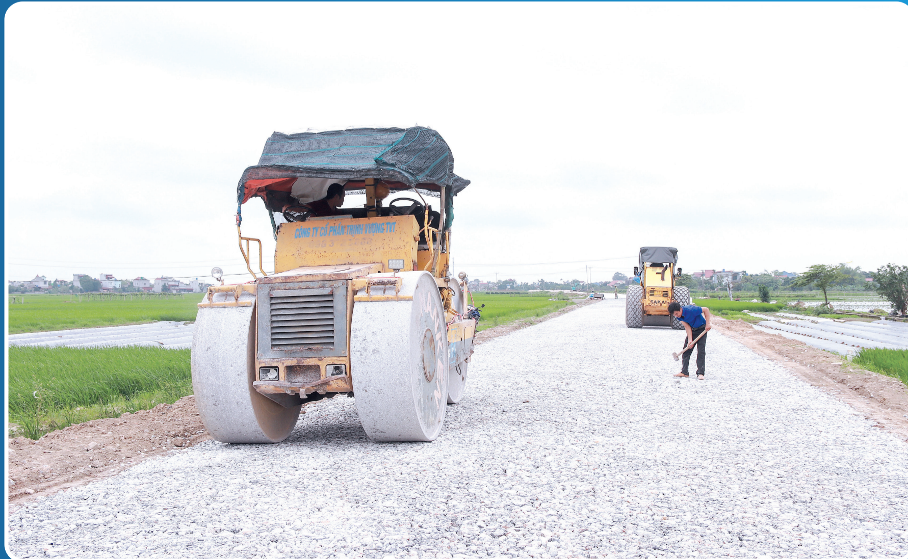
Thi công dự án đường ĐH.90 Thụy Việt - Thụy Ninh.
