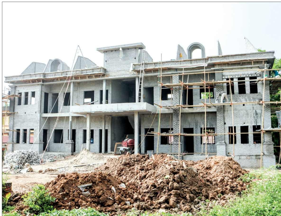
Trụ sở Công an xã Đông Tiến (Quỳnh Phụ) đang được khẩn trương thi công.
