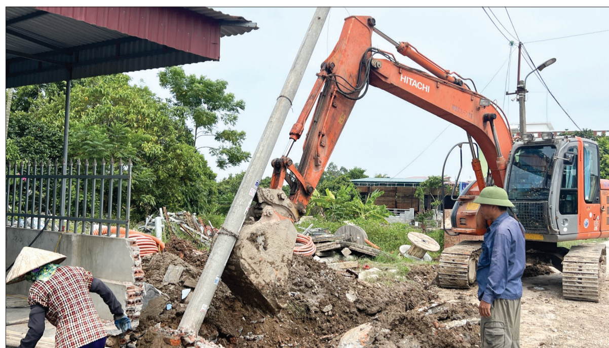
Một hộ dân trên địa bàn xã Thụy Hưng (Thái Thụy) tự nguyện hiến đất để mở rộng đường ĐH.95B.
