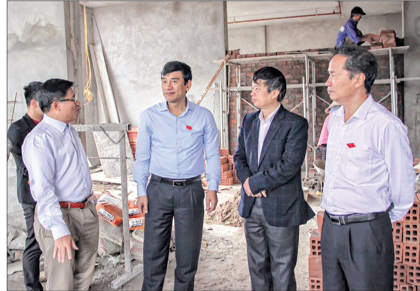
Đồng chí Đặng Trọng Thăng, Phó Bí thư thường trực Tỉnh ủy, Chủ tịch HĐND tỉnh nghe lãnh đạo Công ty Cổ phần Damsan báo cáo tiến độ xây dựng dự án đầu tư xây dựng công trình khu nhà ở xã hội cho người thu nhập thấp tại tổ 39, 40 phường Quang Trung, thành phố Thái Bình.
