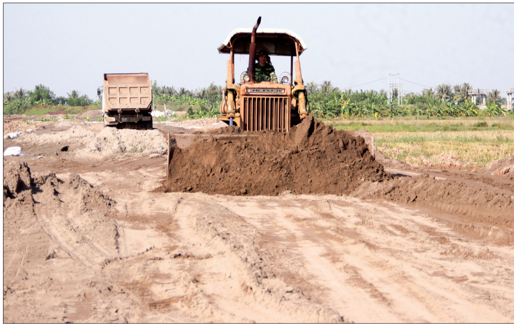
Thi công tuyến đường bộ ven biển tỉnh Thái Bình đoạn qua xã Thụy Trường (Thái Thụy).
