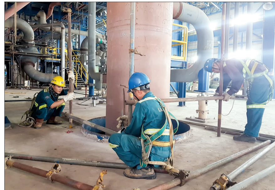
Nhà máy nhiệt điện Thái Bình 2 đã hoàn thành trên 85% khối lượng công việc.
