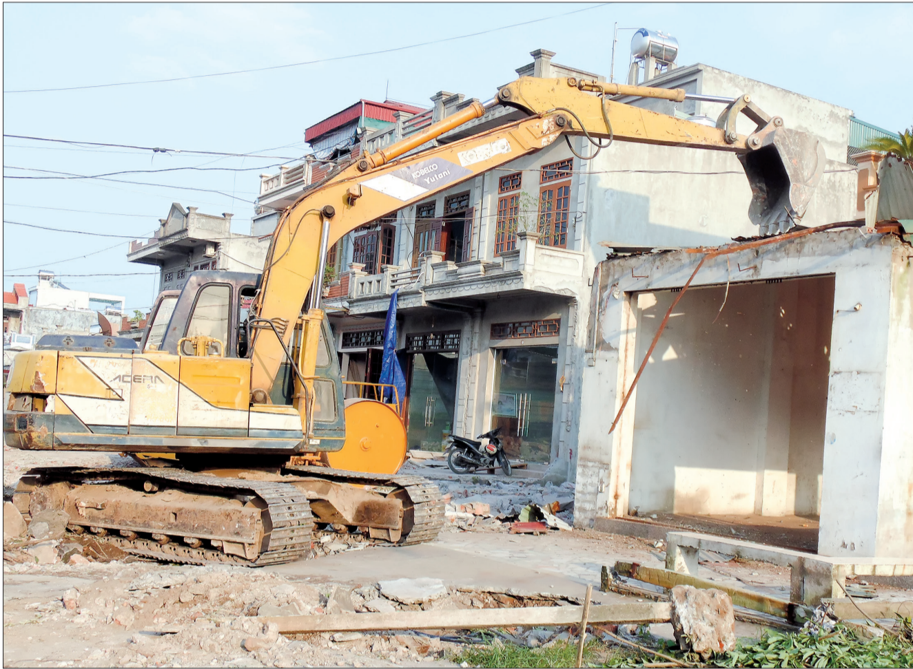
Người dân xã Vũ Phúc (thành phố Thái Bình) tháo dỡ các công trình tạo điều kiện đẩy nhanh tiến độ thi công dự án.
