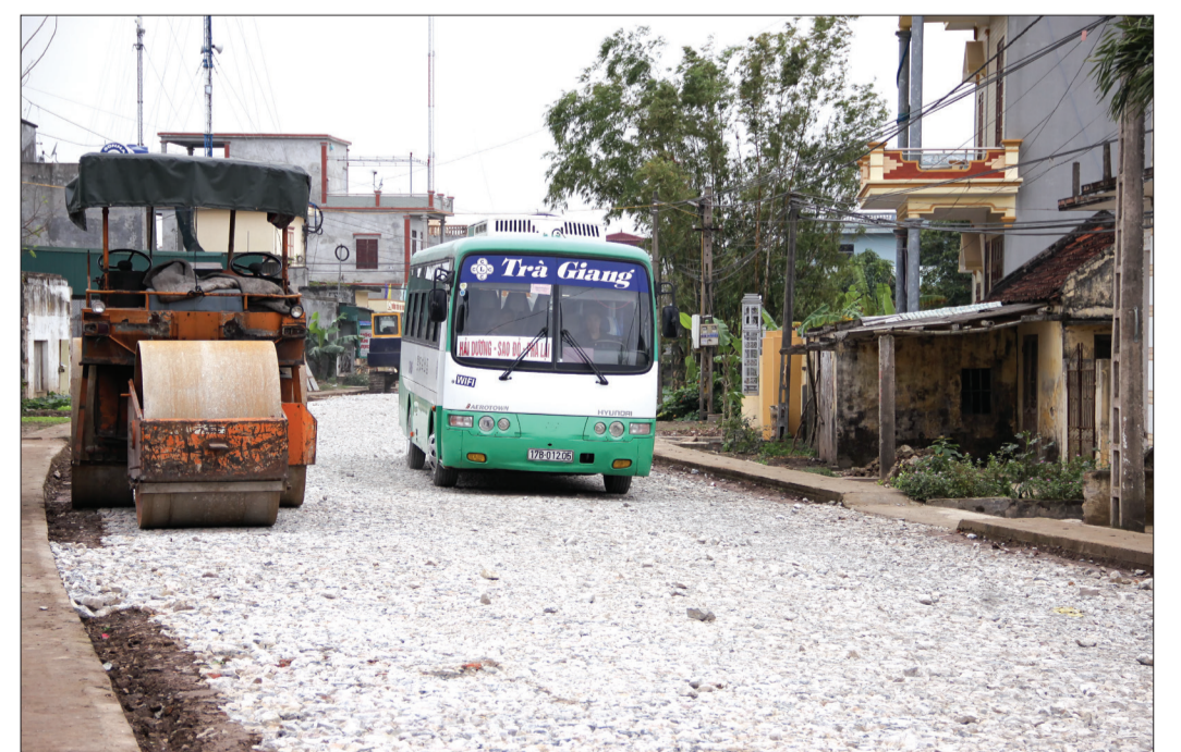
Đường ĐT.457 giai đoạn 1 đoạn qua địa phận thôn Cao Bạt Nang, xã Đình Phùng (Kiến Xương) đang trong quá trình thi công.
