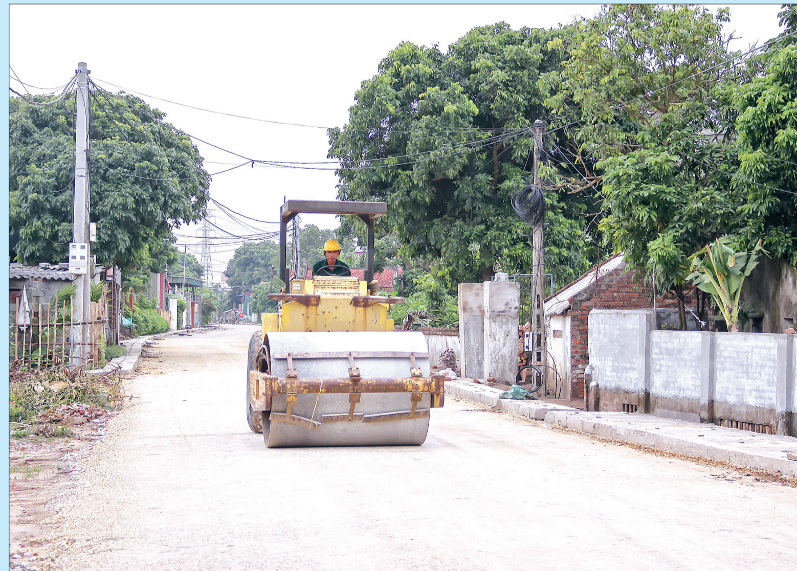
Thi công đường ĐH.64 đoạn qua địa phận xã Thống Nhất (Hưng Hà).
