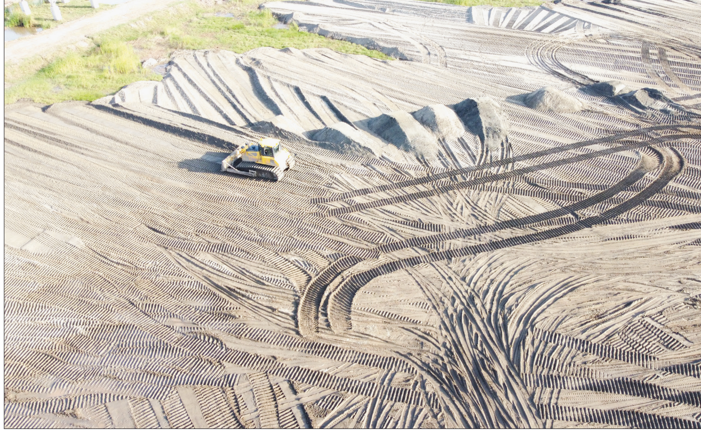
Thái Bình có quỹ đất dành cho phát triển công nghiệp lớn. Trong ảnh: Công tác san lấp mặt bằng tại khu công nghiệp Liên Hà Thái.
