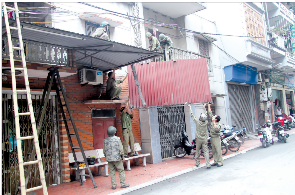
Cựu chiến binh phường Bồ Xuyên (thành phố Thái Bình) hỗ trợ người dân tháo dỡ mái che vi phạm hành lang an toàn giao thông.
