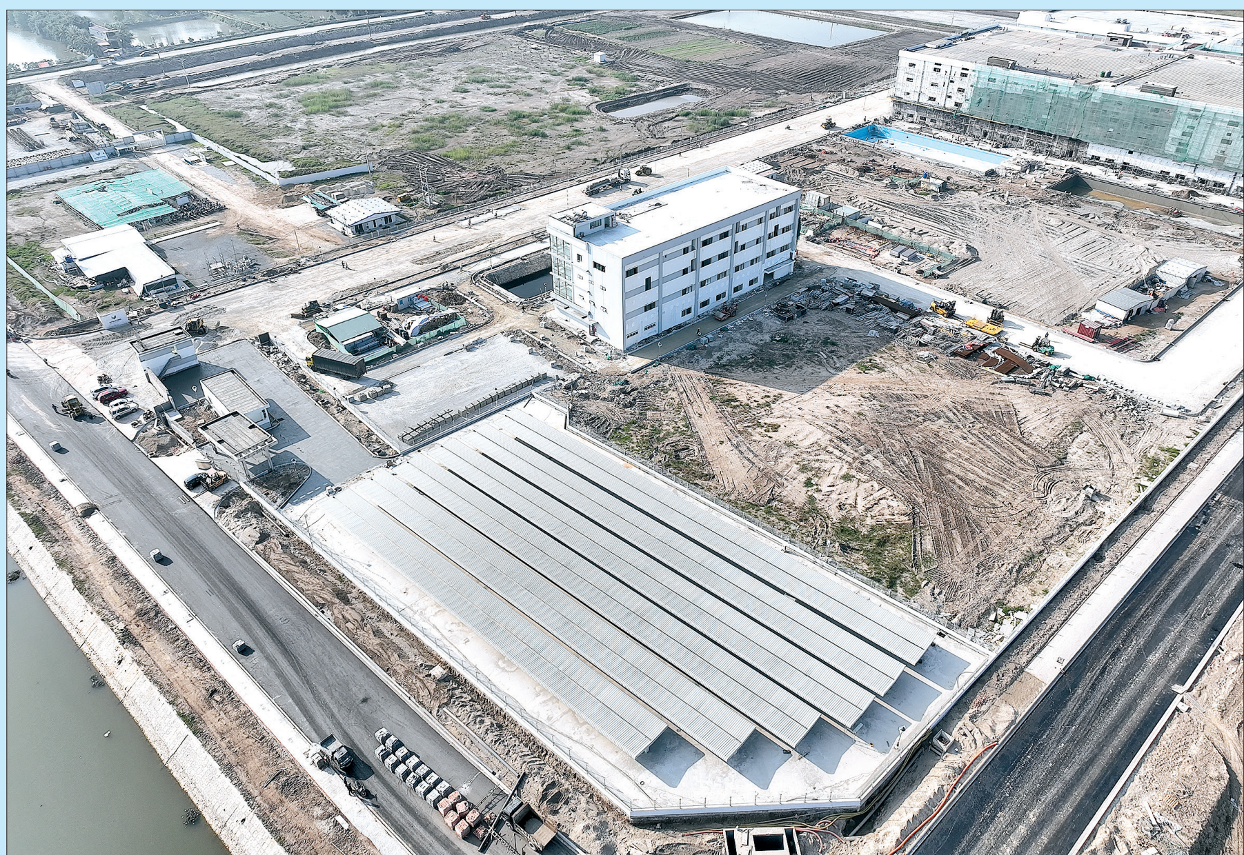
Những công trình, nhà máy đang được xây dựng tại khu công nghiệp Liên Hà Thái.
