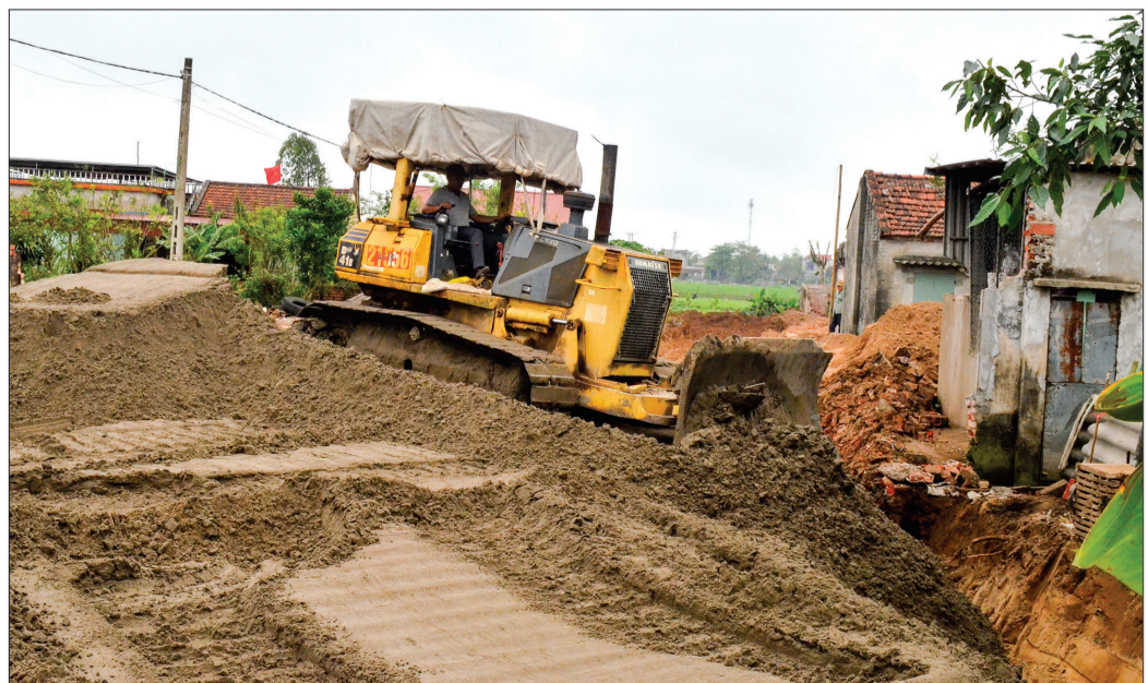
Thi công tuyến đường bộ ven biển đoạn qua địa bàn huyện Thái Thụy.
