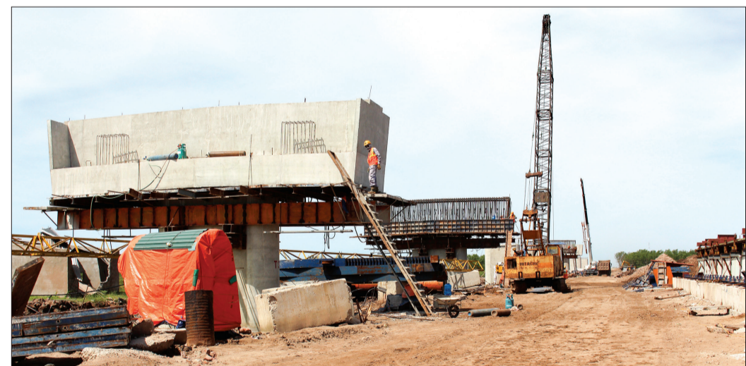
Thi công cầu sông Hồng nối Thái Bình - Nam Định tại dự án tuyến đường bộ ven biển.
