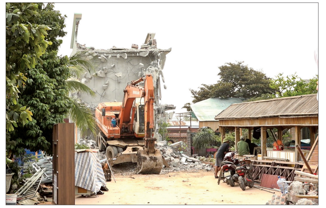
Huyện Thái Thụy tổ chức cưỡng chế tháo dỡ công trình xây dựng trái phép tại xã An Tân.
