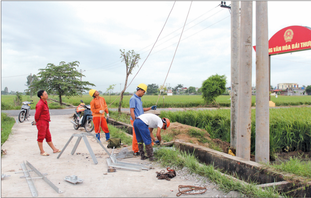
Điện lực Thái Thụy nâng cấp hệ thống đường dây.
